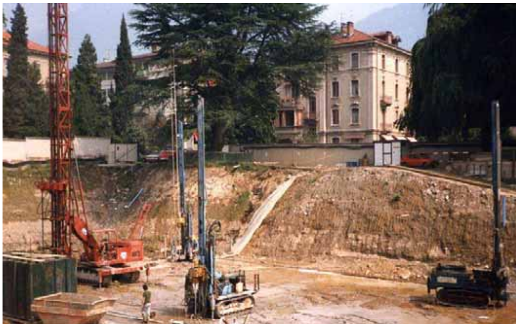
Tampone di fondo nella sede della Banca del Gottardo a Lugano.
